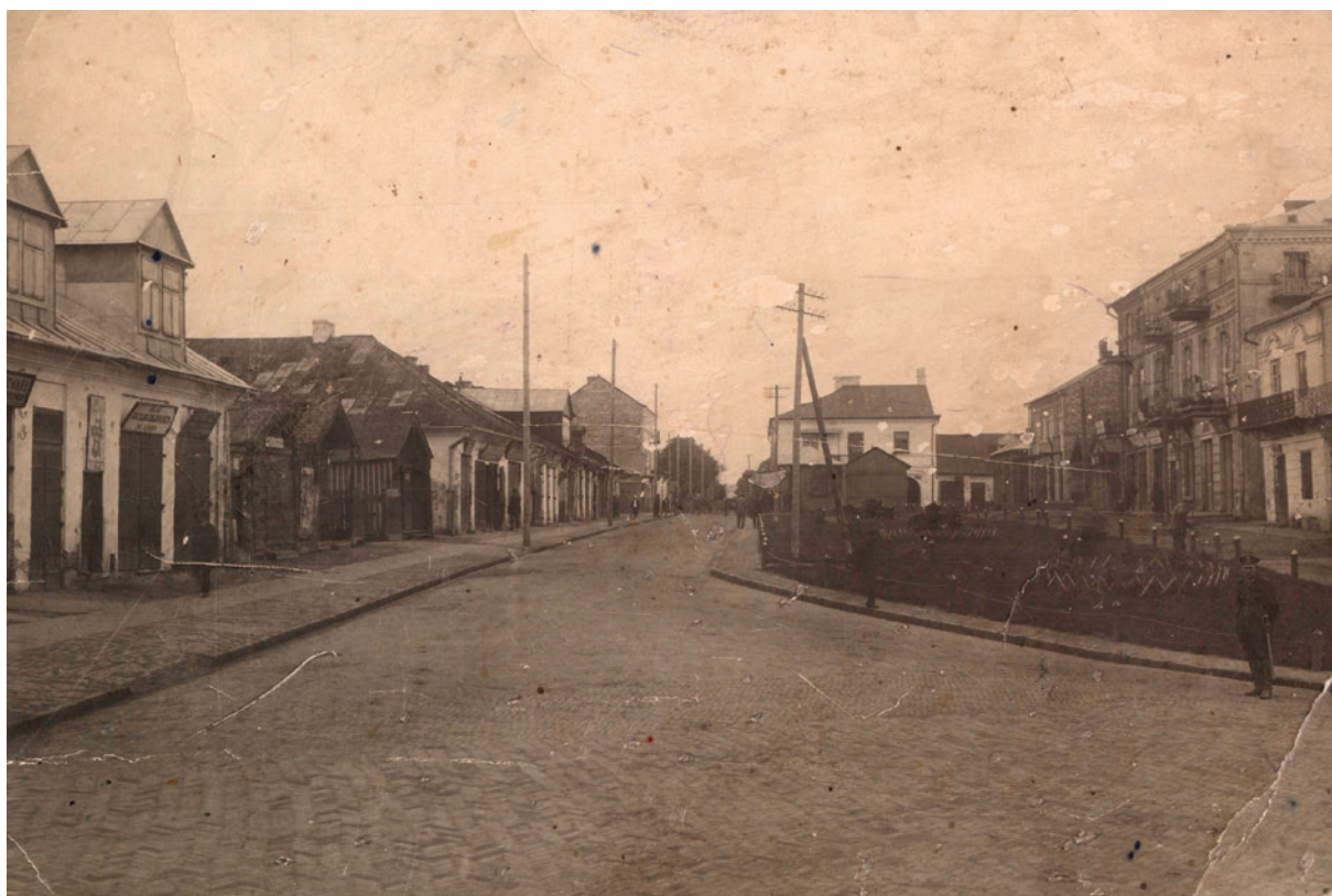
Hrubieszów, Plac Wolności. Po prawej stronie, najwyższy budek to kamienica Orensteinów. Katalog, s. 217, poz. VI.1b.
